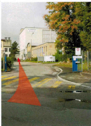
Solistrasse 25 in Bülach Eingang beim roten Pfeil
